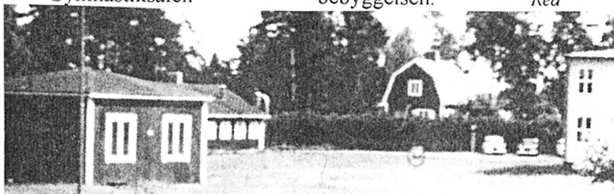
Tre byggnader som inte längre finns kvar: Tjänstebostadsvillan, snickarverkstaden (en gång lektionssal), kubikenborg (en gång radiostation.)
